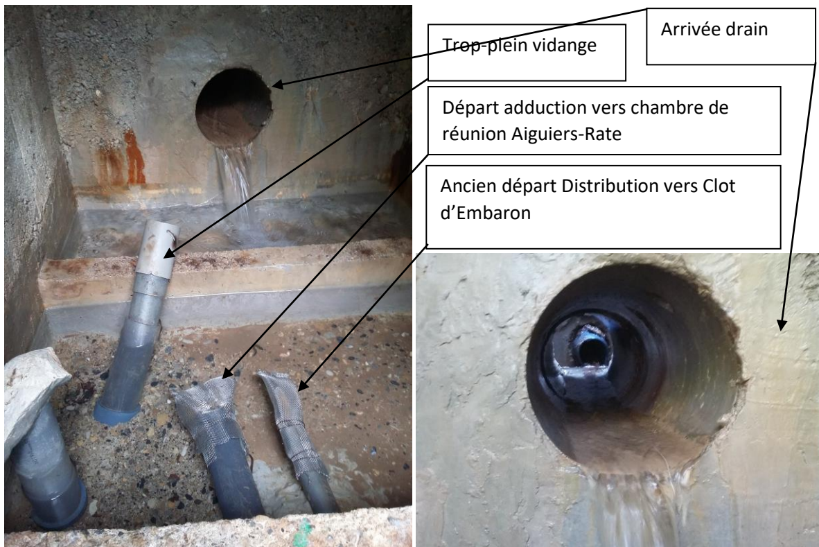
Photo 6: chambre de captage Rate amont et vue de l'arrivée du drain (éclairée par le regard ouvert)
